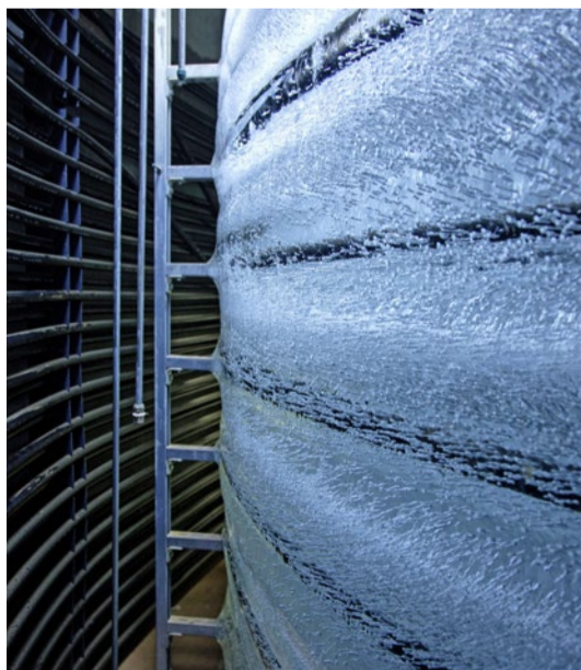
Der Eisspeicher kann ganzjährig genutzt werden (oben, links). Die Gebäudehülle ist als hinterlüftete Holzkonstruktion ausgeführt (oben, rechts).
