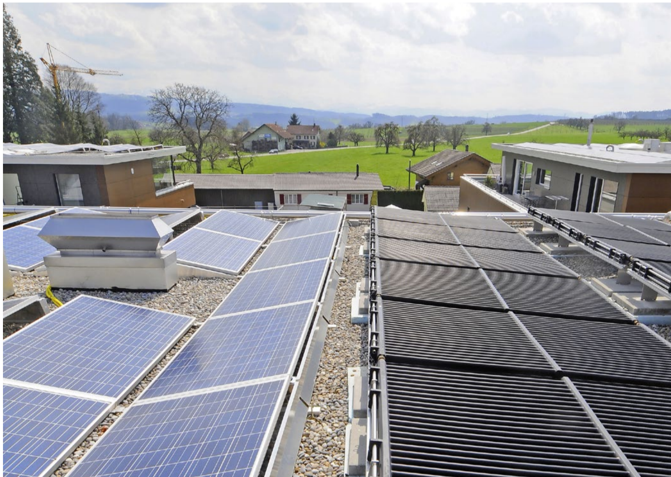
Gut genutzte Dachfläche: Zwei der drei Gebäude sind vollständig mit Photovoltaik-Modulen bedeckt. Das dritte Mehrfamilienhaus trägt neben den PV-Elementen (links) auch die speziellen Absorber für die Regeneration des Eisspeichers (rechts). BILD MICHAEL STAUB
