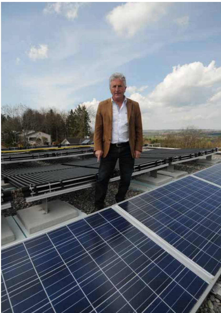
Zwei der drei Häuserdächer sind vollständig mit Photovoltaik-Modulen gedeckt. Auf dem Dach des dritten Hauses steht Bauherr Hanspeter Curiger zwischen PV-Paneln und Solar-/Luftabsorbern (oben). Die Solarwärme kann direkt in den Wärmetauscher des Eisspeichers geleitet werden (unten).
