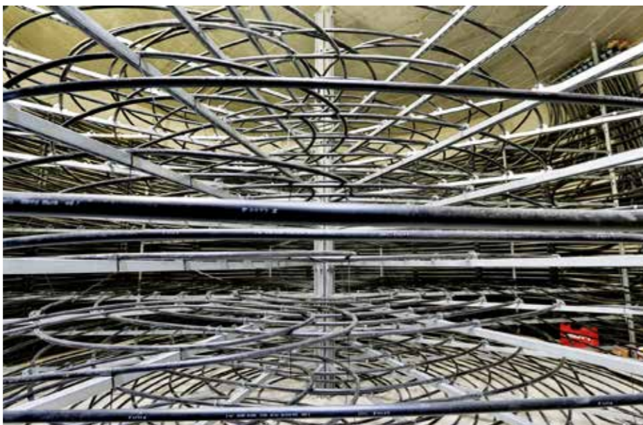
Zwei der drei Häuserdächer sind vollständig mit Photovoltaik-Modulen gedeckt. Auf dem Dach des dritten Hauses steht Bauherr Hanspeter Curiger zwischen PV-Paneln und Solar-/Luftabsorbern (oben). Die Solarwärme kann direkt in den Wärmetauscher des Eisspeichers geleitet werden (unten).
